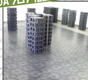
OAフロア化工事
