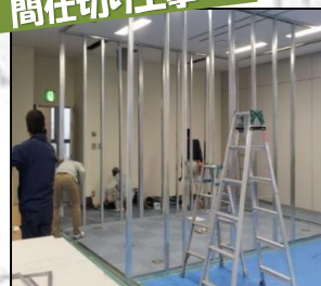
間仕切り工事
